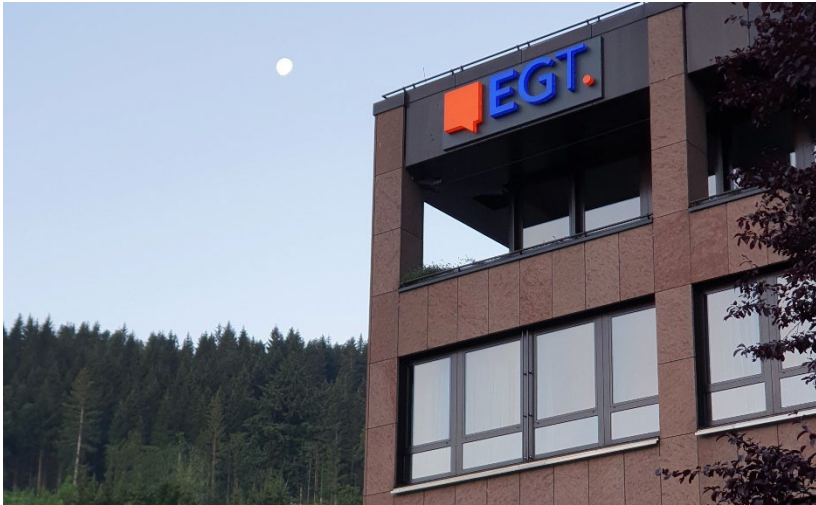
Firmenzentrale der EGT Unternehmensgruppe in Triberg
